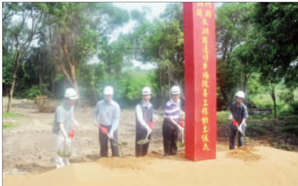
左、「太湖周邊停車場改善工程動土儀式」，陳縣長與建設處長許志忠討論工程應注意事項；右、「太湖周邊停車場改善工程動土儀式」，縣長陳福海、建設處長許志忠、金湖鎮長蔡西湖、金湖鎮代會主席呂瑞泰等人共同執鏟動土。
