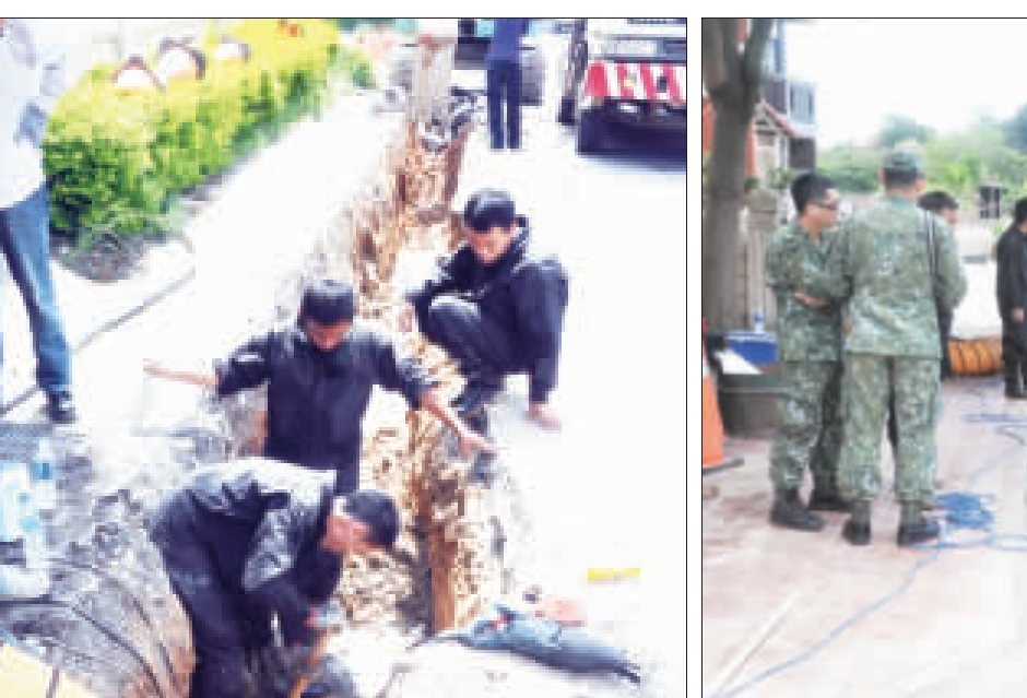
左、金防部派員將阻礙施工的地下廢棄油管移除；右、用怪手將油管吊離地底，油管上可見油汙，現場散發油臭味。（陳冠霖攝）
