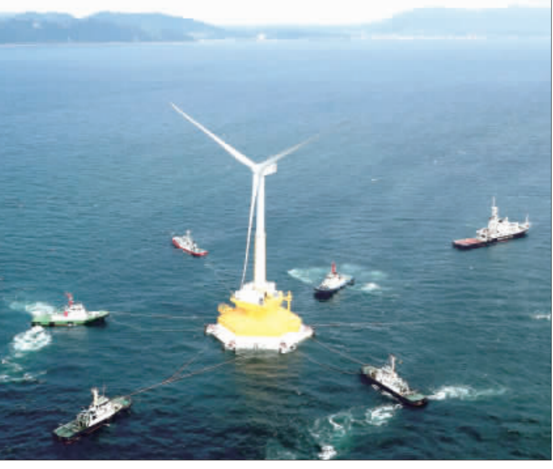
日本1座風力渦輪機正在淡路島海岸外，由多艘拖船拖往福島外海，以便進行海上風力發電實驗。（中央社）
