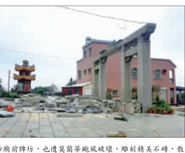
烈嶼保生大帝廟前牌坊，也遭莫蘭蒂颱風破壞，雕刻精美石碑，散落在廟前，地方民眾目擊心傷。(許加泰攝)
