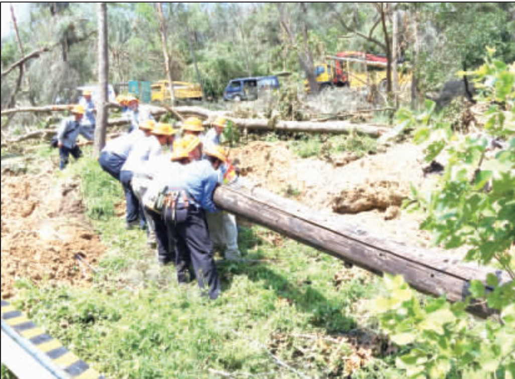
左、縣長陳福海坐鎮本縣應變中心，緊盯梅姬颱風災情；右、在機具無法到達處，台電同仁以最原始人力，排除萬難全力投入全島搶修復電作業。
