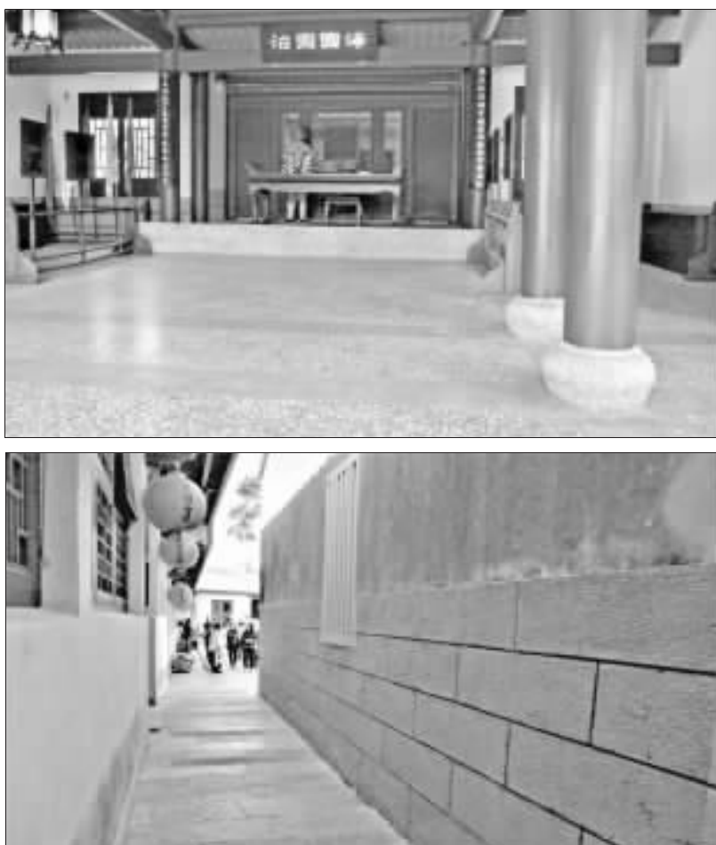
上、下：金城鎮總兵署是明清建古蹟，卻出現突兀的現代磨石子地板與水泥仿石牆。(陳永富攝)
