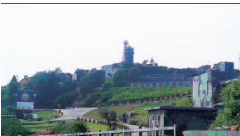
烏坵燈塔復燈是繼去年（105）東引島燈塔復燈後，全由該局同仁自行規劃、設計的第2個案列，安裝工法採取清潔、環保、保留歷史原貌，利用既有結構物採以夾貝方式安裝燈具，未來航港局將在全國各燈塔裝設自動導航系統，善盡海洋國家之義務，全力作好航行安全把關的工作。
