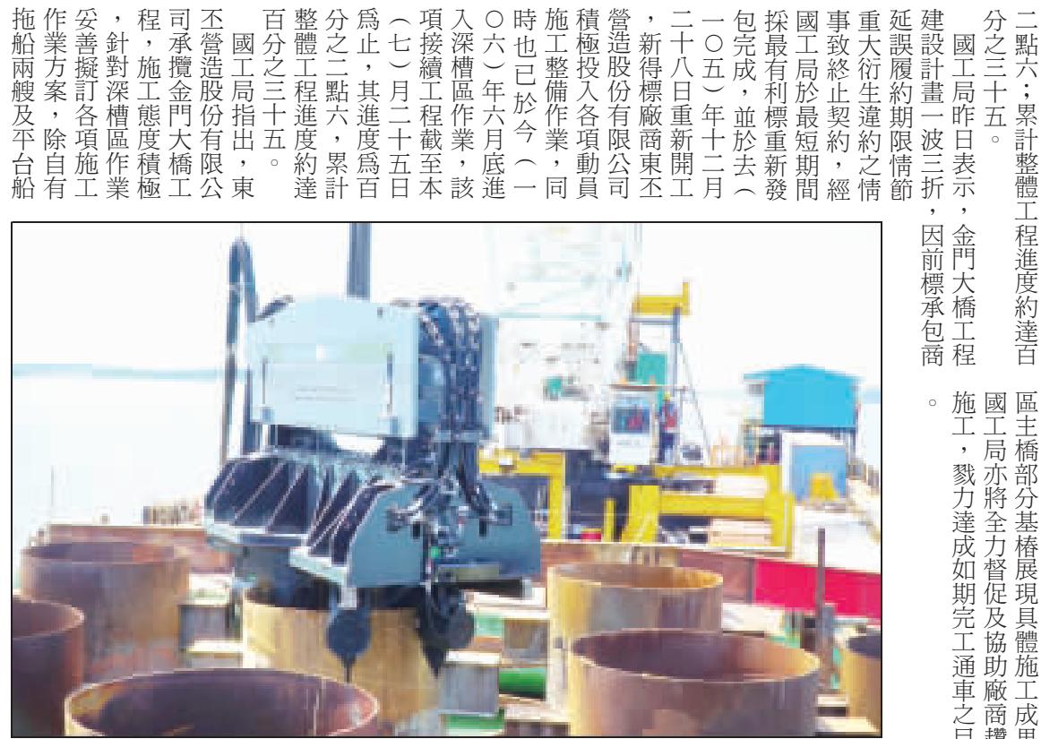
國工局針對大橋進度說明，圖為正在進行中的鋼管拔除作業。
