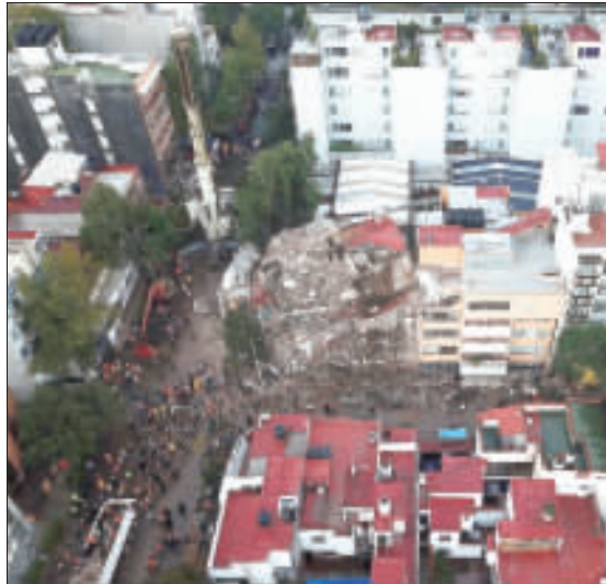
強震重創墨西哥市，搜救團隊在一棟倒塌的建築內尋找生還者。
