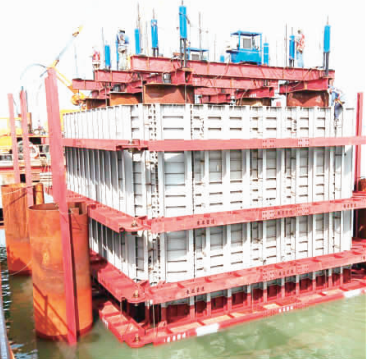
金門大橋工程，完成國內首座海中鋼箱圍堰基礎工程。(高公局提供)
