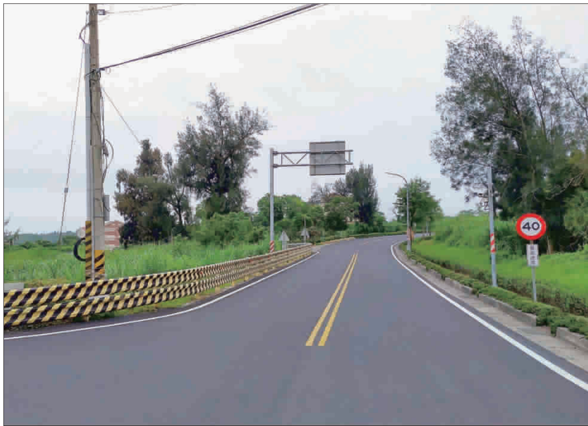
縣府工務處有計畫辦理本縣路平專案，其中珠水路路平改善已啟動施工，並由承商趕進度中。
