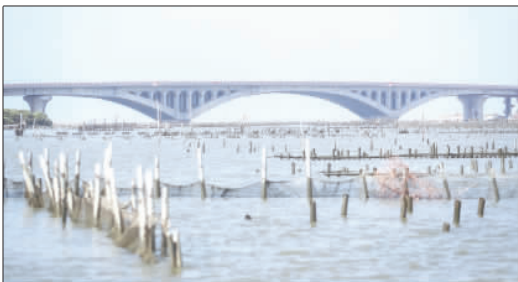
公路總局宣布，西濱快速公路八棟寮至九塊厝工程碳管理及環境減輕策略工程，獲108年度全球道路成就獎的環境減輕類首獎，這也是台灣工程首獲此獎。圖為八棟寮至九塊厝路段七股漫橋。（中央社）
