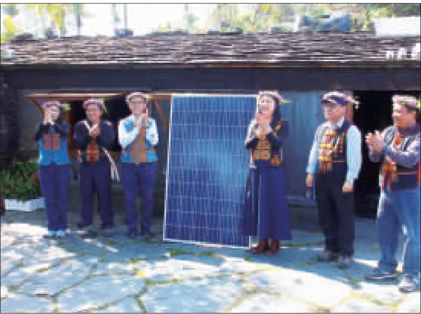
屏東石板屋 裝設太陽能發電 屏東縣政府與排灣族耆老部落合作，在部落13座石板屋設置移動式太陽能發電設備，22日啟用，以不破壞石板屋結構、不改變部落生態環境的低衝擊方式，為部落點亮石板屋。
