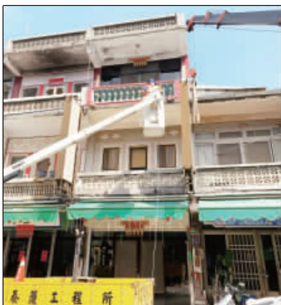
在颱風來臨之前，養工所未雨綢繆先期進行路燈搶修、水溝清淤、危險招牌拆除等演練，冀使災害降至最低。（養工所提供）
