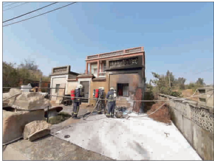
金湖鎮惠民農莊發生住宅火警，消防迅速撲滅，無人傷亡。(金湖消防分隊提供)
