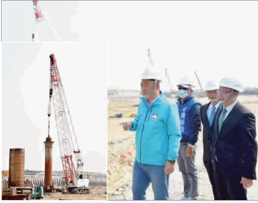
上、金門水頭港大型旅客服務中心新建工程舉辦開工祈福儀式，邀請縣長楊鎮浚等貴賓出席共襄盛舉，祈求該案工程順利、人員平安、諸事圓滿；下、了解工程進度。（廖宗翰攝）
