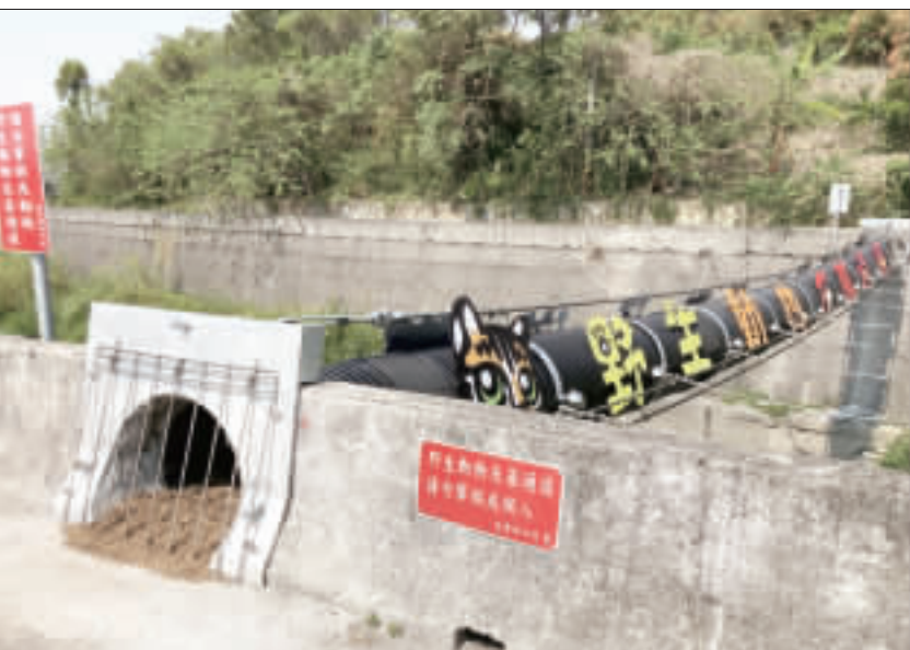
苗栗縣政府首度在老庄溪下游河段搭建2座友善動物通道，盼助石虎等小型野生動物安全穿越溪流兩岸棲地，降低路殺風險。（中央社）
