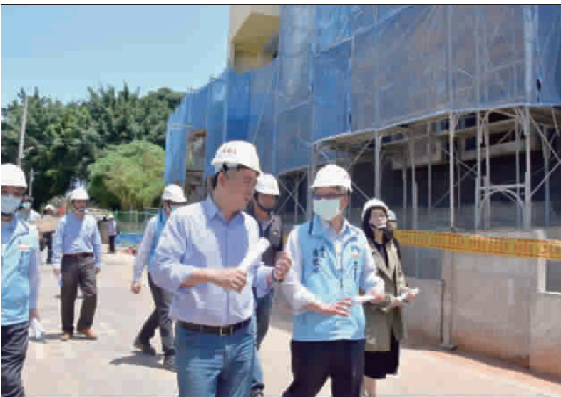
上、縣長楊鴻浩視察湖埔幼兒園教學大樓施工情形，強調品質管工安並關心校務發展；下、現場聽取主辦單位簡報。
