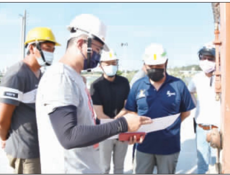
左、右：夏墅社區道路改善，金城鎮長李誠智責成施工廠商分段施工，方便社區居民出入。（廖宗翰攝）
