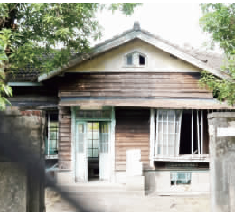
位處台南市舊城核心的日治「原台南刑務所木造建築群」，始建於1924年，2005年一度因管理不當而失火，市府積極向中央爭取到補助，預定110年底首度啟動修復。
