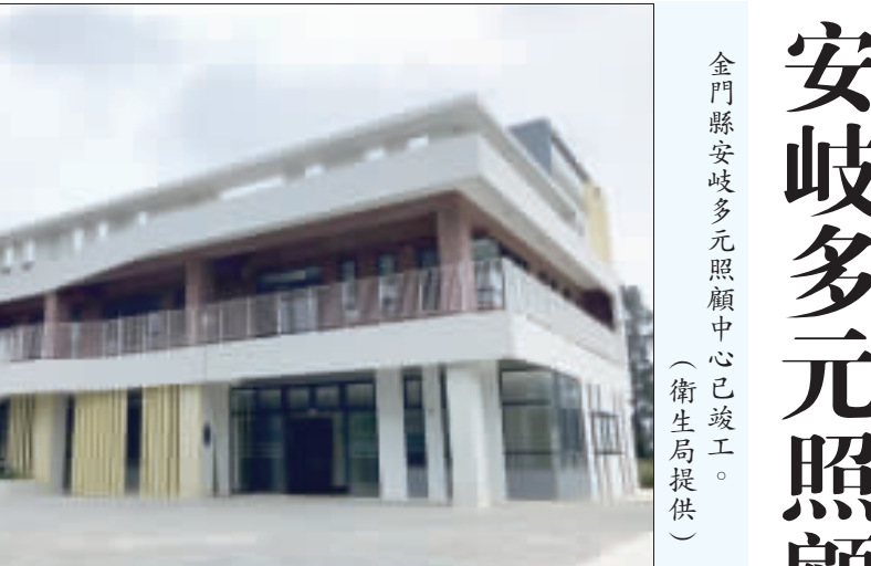
安岐多元照顧中心已竣工。(衛生局提供)
