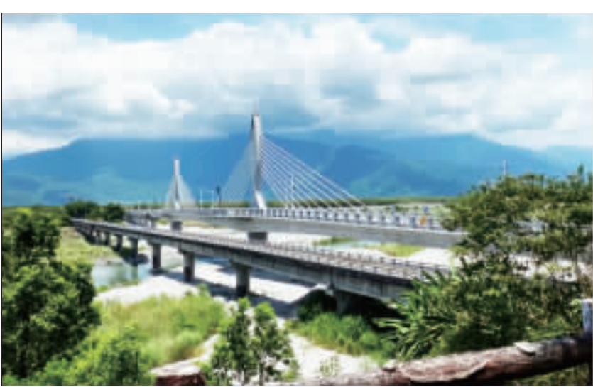
花蓮縣鳳林鎮箭瑛大橋是紀念44年前因公殉職的老師張箭、鄧玉瑛，因舊橋老舊、狹窄，縣府爭取經費在舊橋北端興建二代橋梁，29日正式通車。
