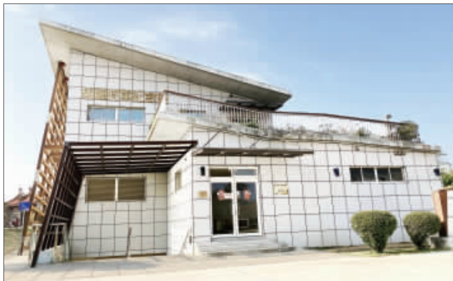
胡璉將軍紀念館將進行修繕，施工期間依然開放入內參觀，遊客須配合現場各項管制措施。（金門國家公園提供）
