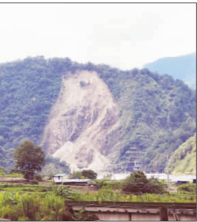
南投縣仁愛鄉「投83線」25公里處大規模坍方，土石完全推毀道路，甚至滑落下方武界壩水庫，遠眺可見崩塌範圍相當大。（仁愛鄉公所提供/中央社）
