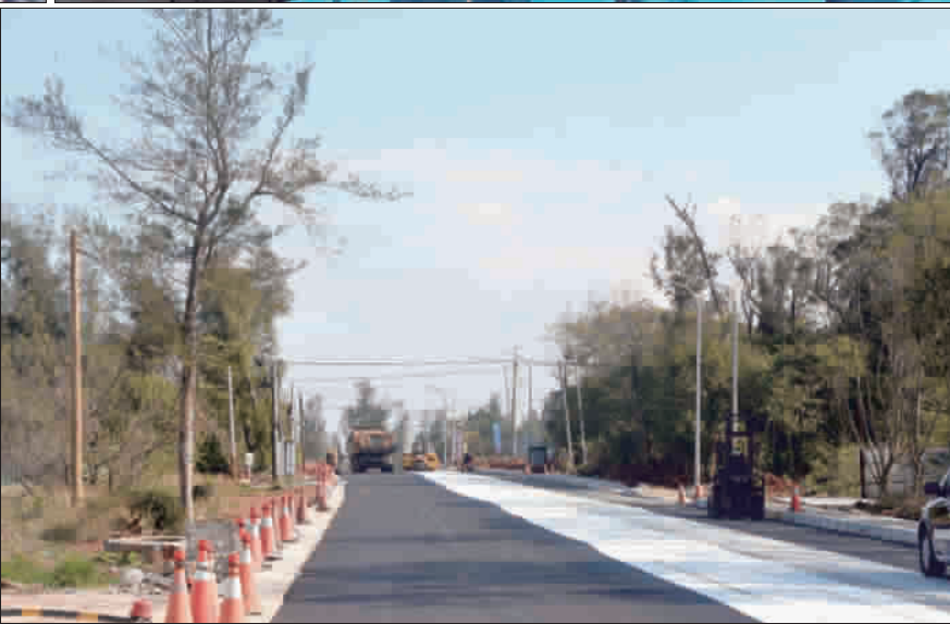
右上、縣長楊鎮浚在工務處長許鴻志、副處長黃儒新等人陪同下，視察環島北路一段、環島北路三段及高陽路道路拓寬工程，期許施工路段早日解除封路，確保鄉親在年節期間能有更為順暢的交通；左上、楊鎮浚縣長聽取監造單位簡報道路拓寬工程施工進度；右下、在承商的全力趕工下，環島北路一段可望在農曆年前解除封路恢復通車；左下、承商在拓寬路面鋪設防裂網，延緩未來路面的裂縫產生。（翁維智攝）
