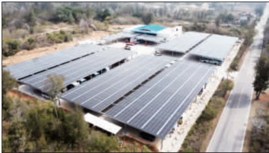
建華保養廠陽光車棚，使用3910片太陽能板，每年可發151萬度電，足以供應金門430戶全年用電。（車船處提供）
