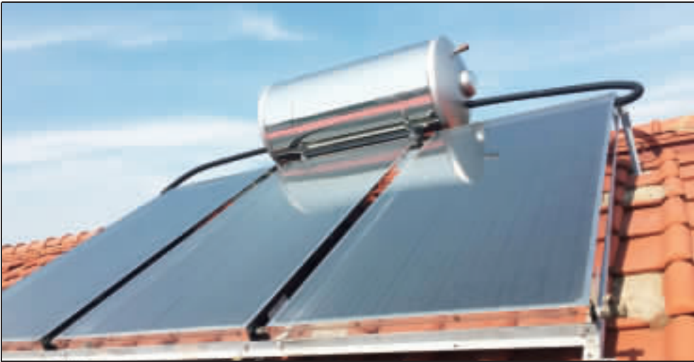
金門縣政府推廣太陽能熱水器新增單元補助，即起歡迎踴躍申請，圖為太陽能熱水器主要元件：儲熱水桶及集熱面板。（建設處提供）
