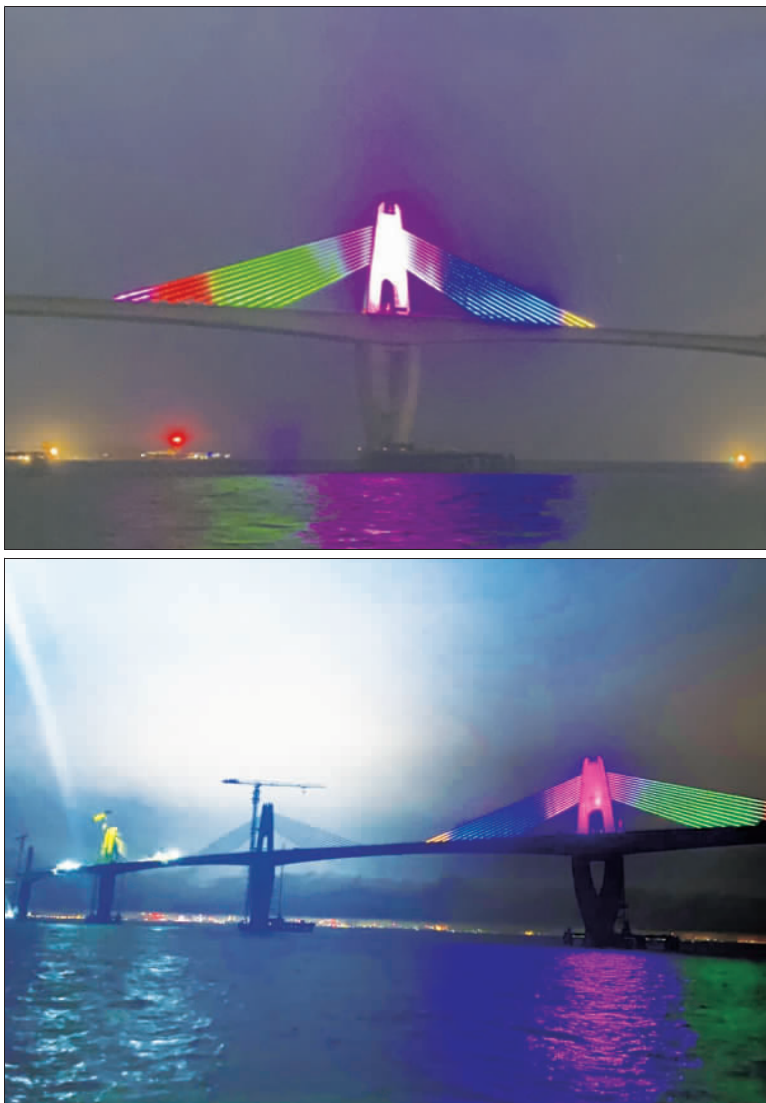
連接金門本島和烈嶼鄉的金門大橋預計9月底完工、10月底通車，施工單位21日晚間進行其中一塔全彩LED投射燈效果測試，七彩絢麗燈光在夜間閃爍，讓民眾驚呼連連。（金門縣政府工務處提供）
