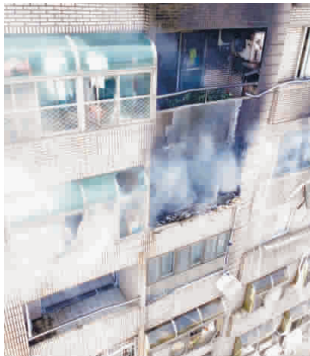
新竹縣竹北市24日上午瓦斯加壓站壓力異常，造成市區多處民宅瓦斯外洩，1大樓氣爆，新竹縣消防局出動搶救。
