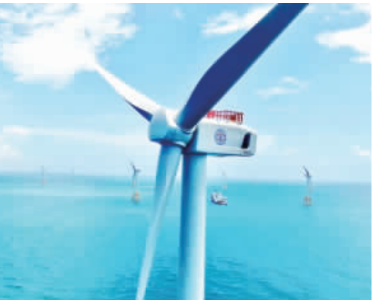
台電肩負政策任務，除釋出自建綠電供給市場，也持續開發再生能源，主力為太陽光電、離岸風電所組成的「風光」軍團，力拚發電量倍數成長。圖為台電離岸一期風力發電。(台電提供／中央社)
