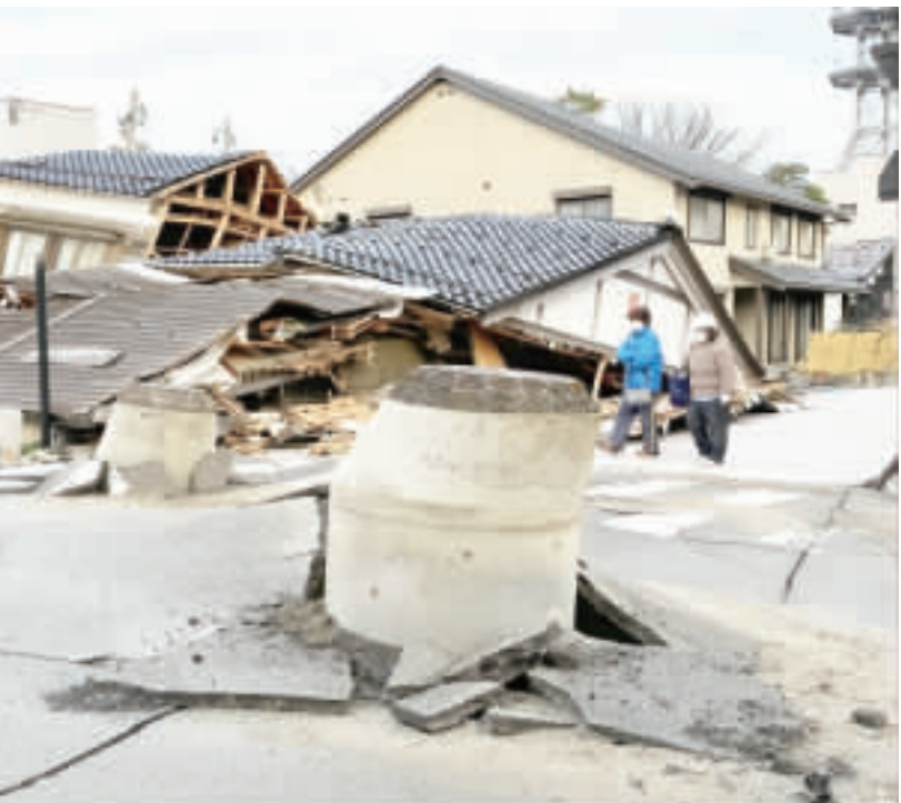
左、日本石川縣能登半島元旦發生強震，輪島市漆器店大徹吉峰庵、一旁的大徹漆資料館被震毀，專家憂心漆藝文化因這場強震而消失；右、輪島市遭遇震度7級強震，人孔突出地面。（中央社）
