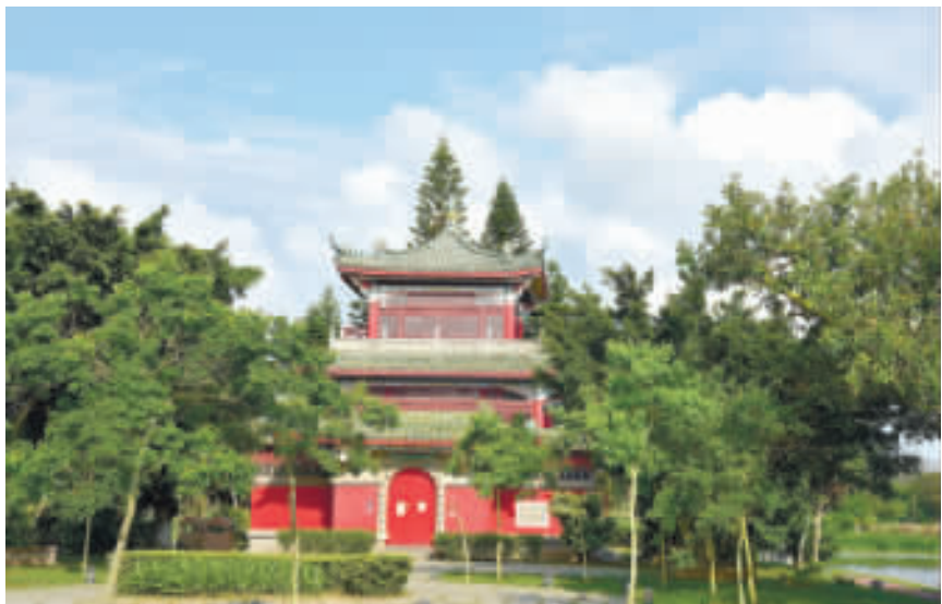
古崗樓1樓內部展示整修將於113年7月11日至8月31日施作暫停開放。（金管處提供）
