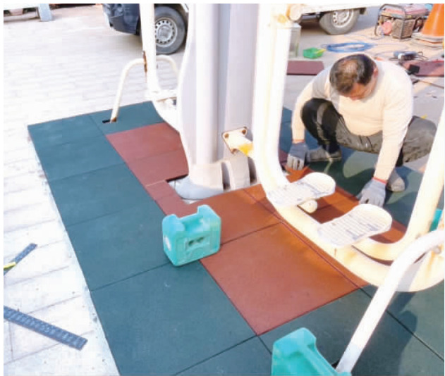
金寧鄉公所為公共遊具進行全面維修。(金寧鄉公所提供)
