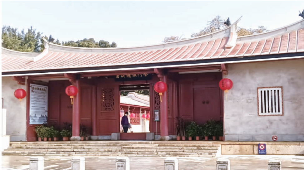
金門縣啟動後浦清金門鎮總兵署颱風災損修復工程，堅持文化永續發展。(李增汪攝)
