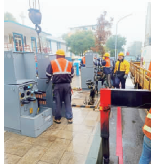
台電公司金門區處對金城車站一帶用戶進行計劃性停電，台電工作人員冒雨趕工，更換新變壓器。（台電公司金門區處提供）
