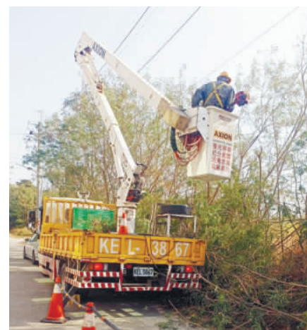
圖為配電線路的維護，防範鳥獸造成停電事故發生。（台電金門區處提供）
