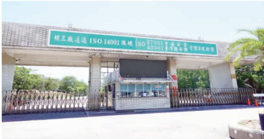
台電核三廠2號機17日完成停機後，也代表核三廠將正式除役，結束40年商轉，台灣將邁入非核家園。圖為核三廠廠區大門。（中央社）
