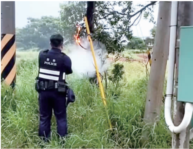
電線桿起火，金寧分駐所員警先期滅火。（金城分局提供）
