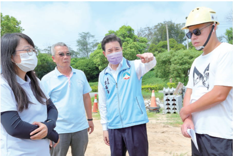
縣長陳福海前往金沙鎮沙溪青年住宅公共設施工程現場，關心施工進度。（薛子軒攝）
