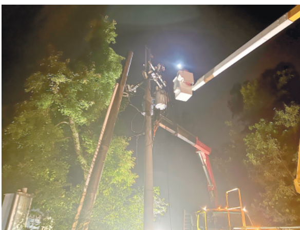
台電人員搶修復電。（台電金門區處提供）
