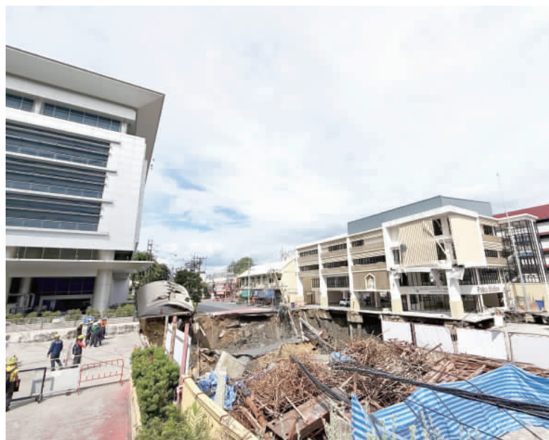
泰國曼谷市區的馬路24日突然嚴重塌陷，形成約30平方公尺、深50公尺的巨大天坑。（中央社）
