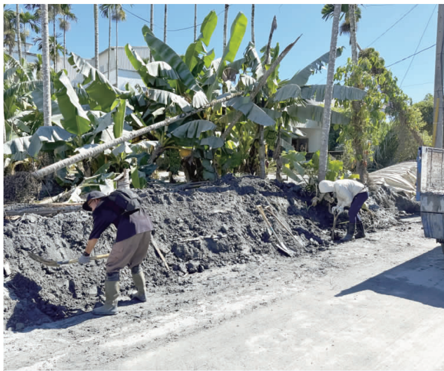
中秋連假進入第2天，花蓮光復災區隨處仍可見鏟子超人，協助清理災區路邊淤泥。（中央社）
