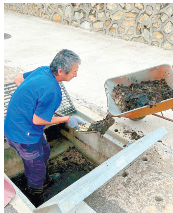
易淹水區水溝清淤。（金沙鎮公所提供）
