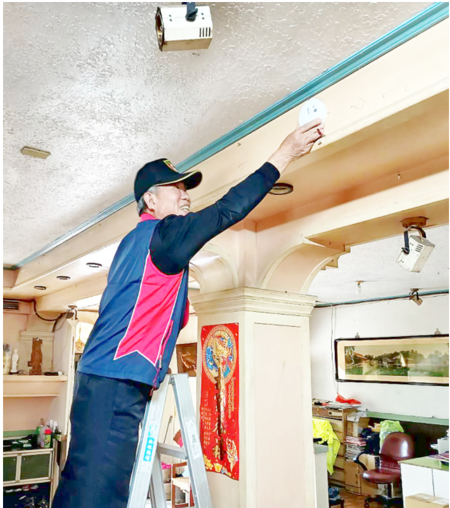
左、消防局結合精忠衛隊成員，協助安裝住宅用火災警報器；右、公私協力打造居家防火安全網。
