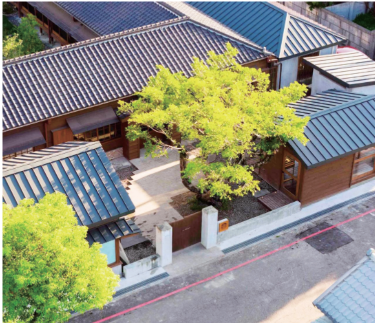
羅東林場「木造長屋招待所、洗衣部修復工程」保存林場不同時期形成的生活服務建築群，日前榮獲國家卓越建設獎最佳環境文化類金質獎肯定。(林業及自然保育署宜蘭分署提供/中央社)
